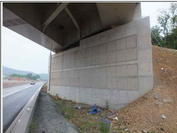
내 용 영천JCT Ramp-A교 교대
