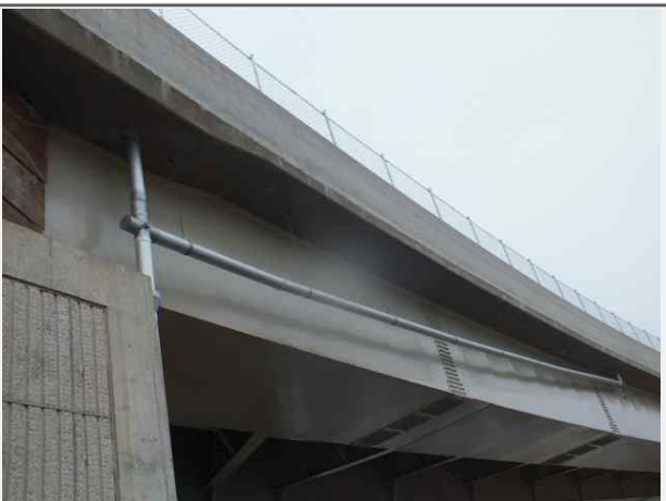
내 용 영천JCT Ramp-A교 배수관
