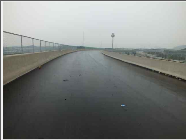
내 용 영천JCT Ramp-A교 상부
