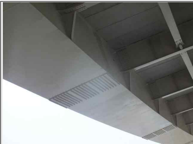
내 용 영천JCT Ramp-A교 거더
