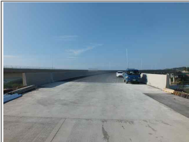
내 용 영천JCT Ramp-B교 상부
