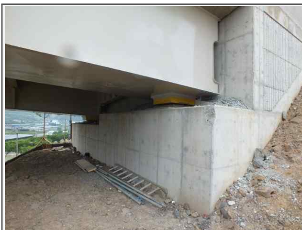
내 용 영천JCT Ramp-B교 교대
