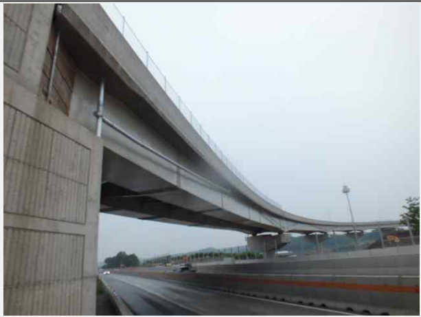
내 용 영천JCT Ramp-A교 측면
