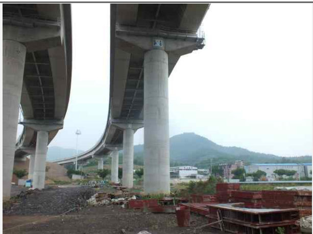
내 용 영천JCT Ramp-A교 교각
