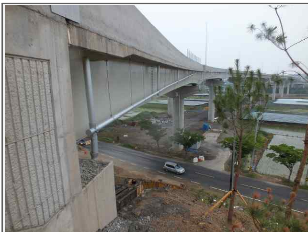
내 용 영천JCT Ramp-B교 거더
