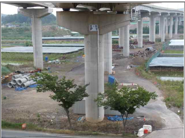
내 용 영천JCT Ramp-B교 교각
