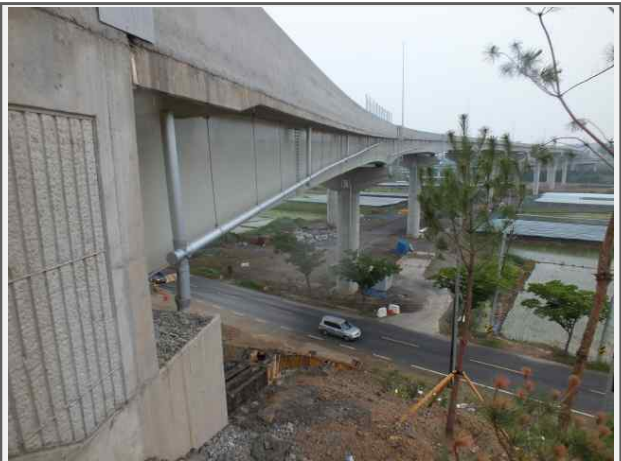
내 용 영천JCT Ramp-B교 측면
